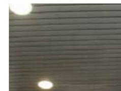
Decke aus Alulamellen, stark vergilbt, mit runden Einbaustrahlern, Vordach
